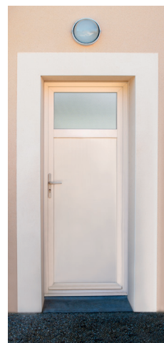
Porte de service vitrée en partie haute.
