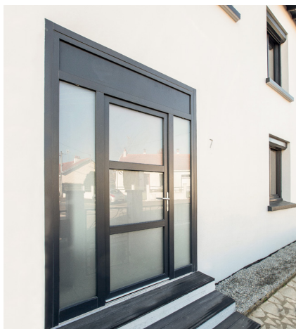
Ensemble composé d'une porte serrure Kyoto, de 2 fixes vitrées latérales et d'une imposte pleine fixe en gris anthracite
